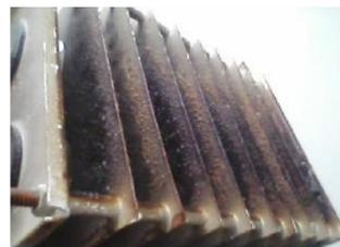
Os módulos eletrostáticos são constituído de um grupo de lamina (positiva e negativa) de material nobre que ao energizar libera trilhões de ions negativos, atuando na quebra das moléculas de gordura as polarizando, e por meio do princípio da estática e da atração de cargas eletricamente opostas os particulados graxos são atraídos para as
