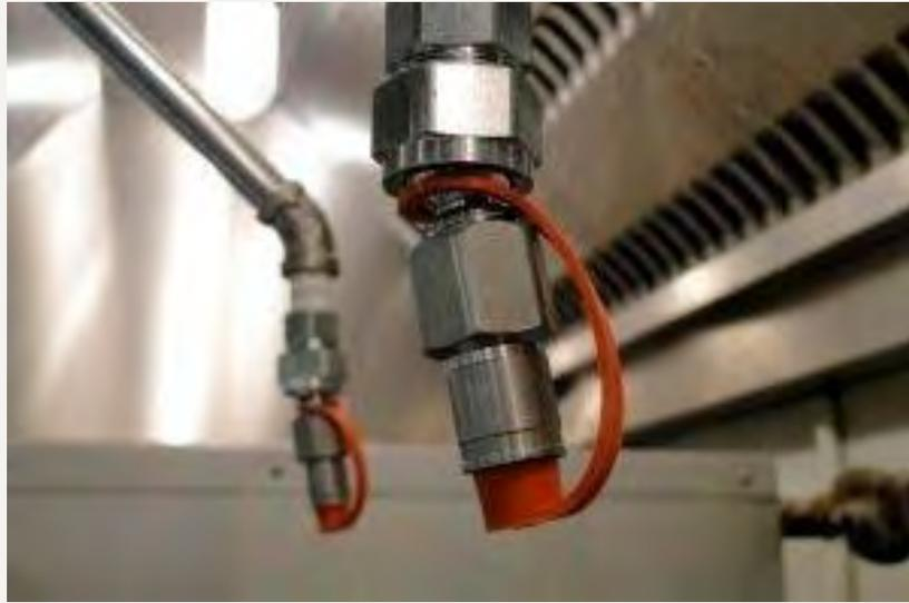
Nossa solução de combate a incêndio entra em ação automaticamente ao detectar um incêndio. O sistema é equipado com um módulo que interrompe o
