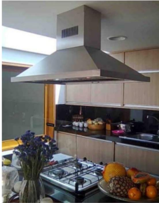
Coifa Residencial, para fogão 4 queimadores doméstico a gás, ou elétrico. Com dois dutos, que deslizam um dentro do outro, sendo o de baixo, onde tem todo o sistema, vai o motor, conjunto trafo e módulo filtrante, e o duto de cima, é por onde o ar retorna limpo ionizado, de volta ao ambiente.
