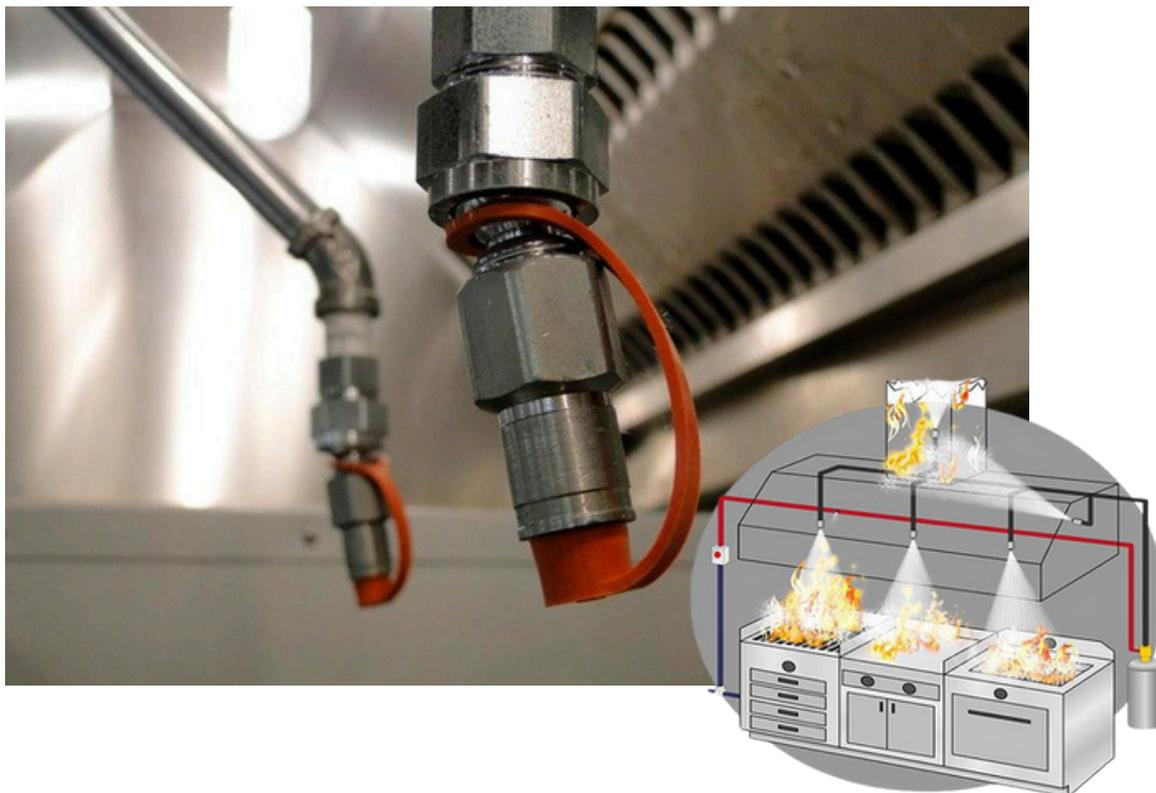
O sistema é equipado com um módulo que interrompe o fornecimento de gás e eletricidade para os equipamentos da cozinha, evitando a propagação do fogo. A extinção completa do fogo é garantida devido à presença de gordura saturada em materiais utilizados na cocção. Quando esta gordura entra em contato com o agente extintor à base alcalina (como o extintor classe K), a altas temperaturas, ocorre uma reação chamada de saponificação.
