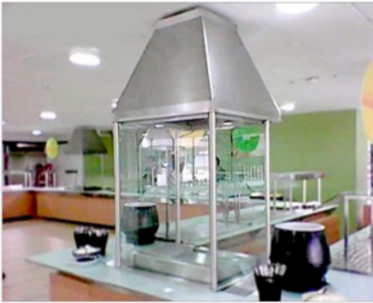
Coifa instalada no refeitório da volkswagen
